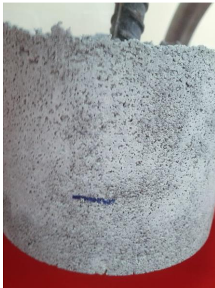
Ilustración D.6 Superficie de cilindro de cemento con inhibidor antes del ensayo de corrosión acelerada – muestra 3
