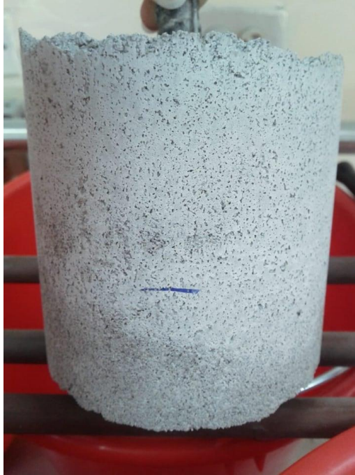
Ilustración D.3 Superficie de cilindro de cemento sin inhibidor antes del ensayo de corrosión acelerada – muestra 3
