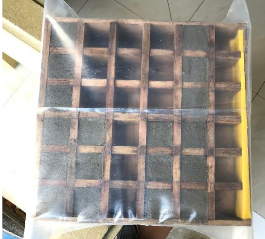
Ilustración B.4 Colocación de mezcla de geopolímero en moldes para su posterior curado
