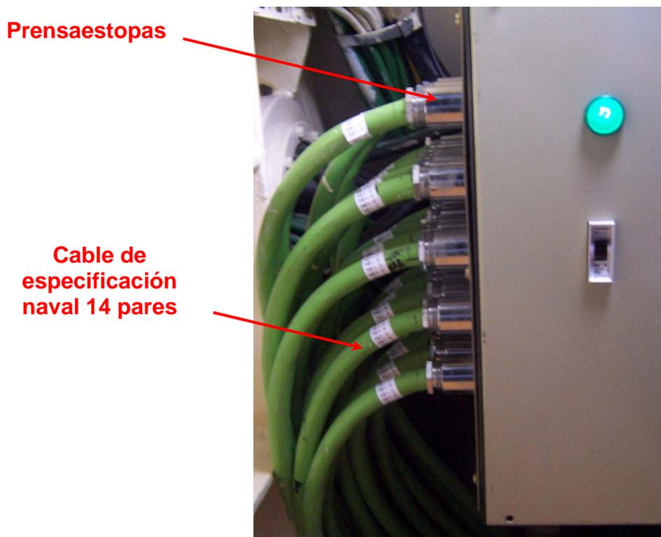
**Figura 2.1.-** Cables y prensaestopas de especificaciones navales
