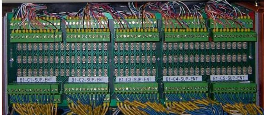
**Figura 3.19.-** Tarjeta de fusibles
