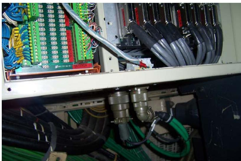
**Figura 2.3.-** Conectores circulares de comunicación y poder
