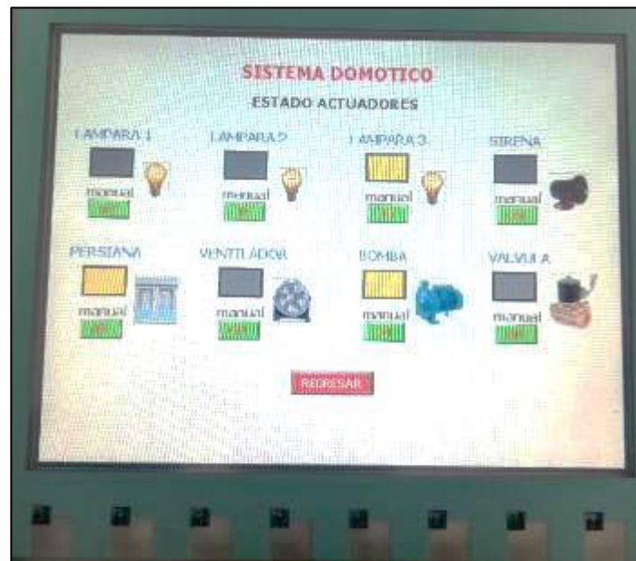
Figura 4.4 Monitoreo señales de sensores desde el controlador LOGO
