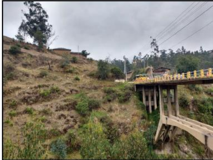
Ilustración 4-4 Zona de estudio, apreciación de fuerte relieve.
