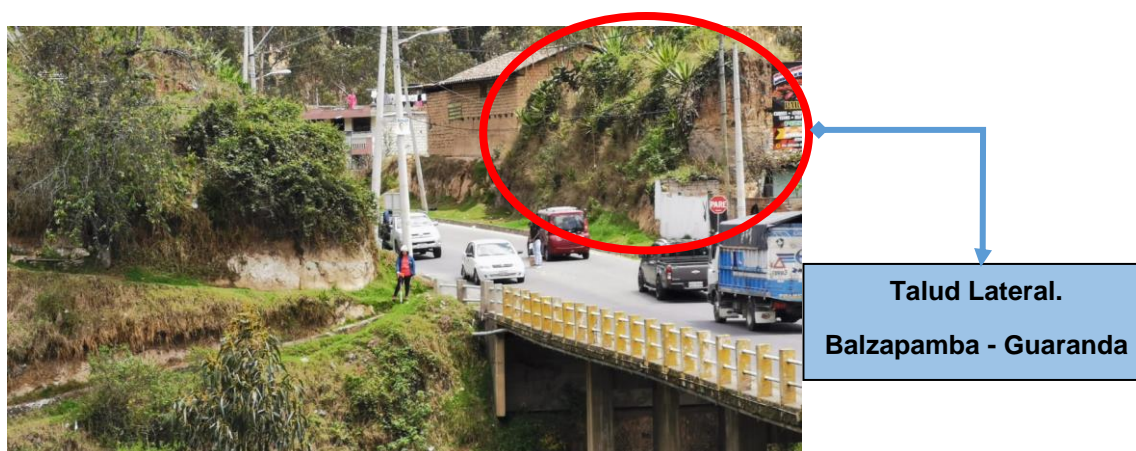
Ilustración 2-17 Taludes aledaños al puente.
