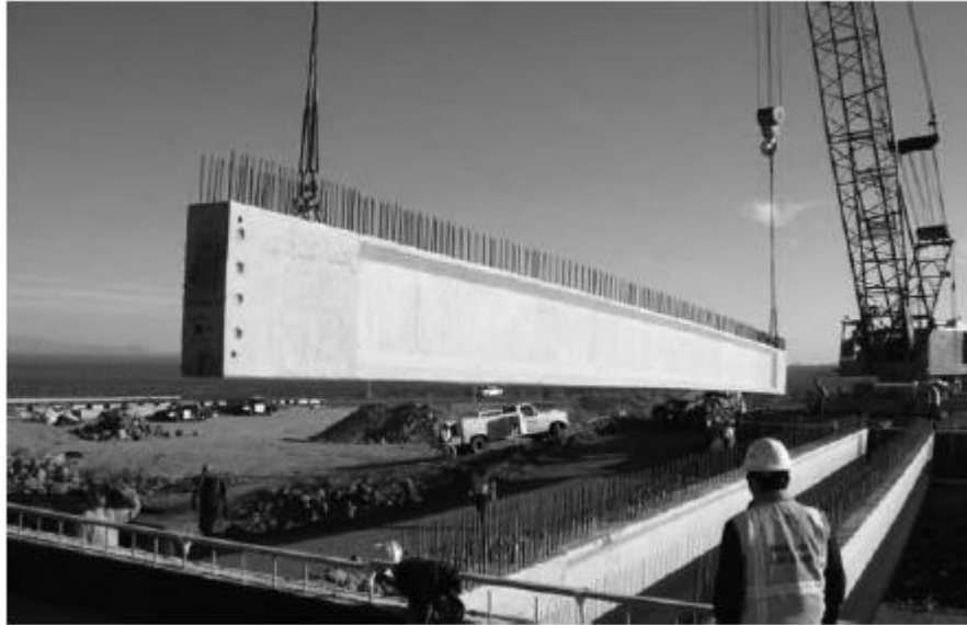
Ilustración 2-8 Viga de Concreto Presforzado.
