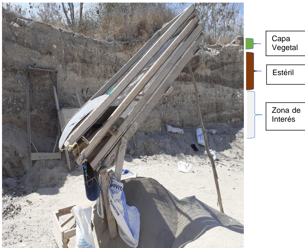
Figura 2.3 Frente de explotación, material de interés, estéril y capa vegetal. Fuente: Gencón, J., 2020.
