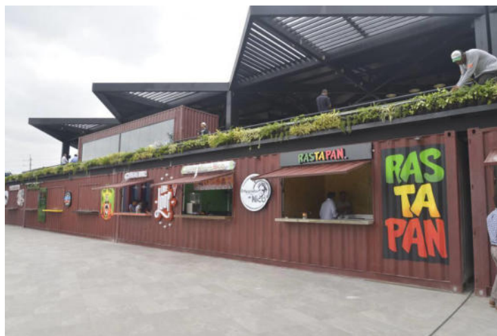
Figura 2.11: Plaza Guayarte realizada con contenedores
