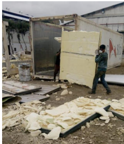
Figura 3.2: Retiro de plancha de espuma
