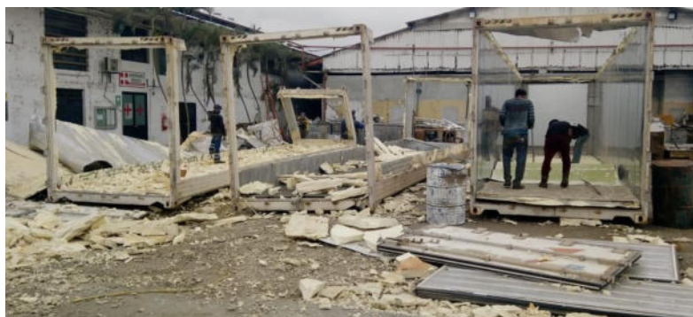
Figura 3.3: Retiro del piso del contenedor
