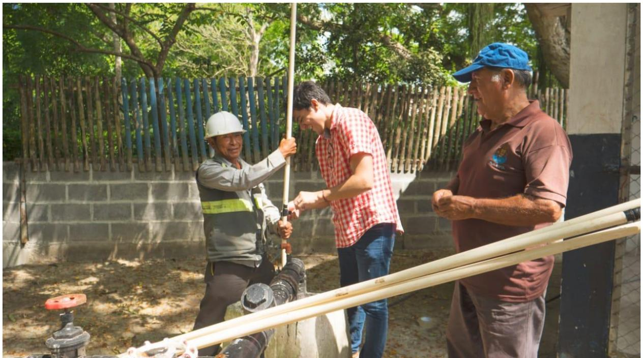
**Figura A. 49.** Preparación de tubos PVC de ½ pulgada para la inserción del sensor de la sonda en cada pozo.
