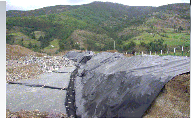
Impermeabilización del suelo para evitar filtración lixiviados
