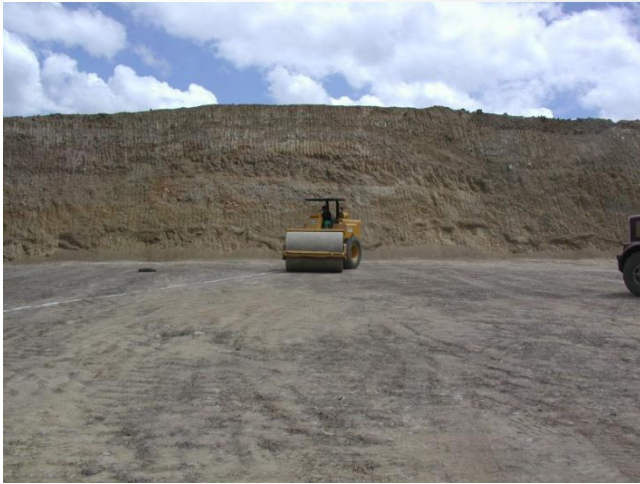
Compactación del suelo primera capa de arcilla
