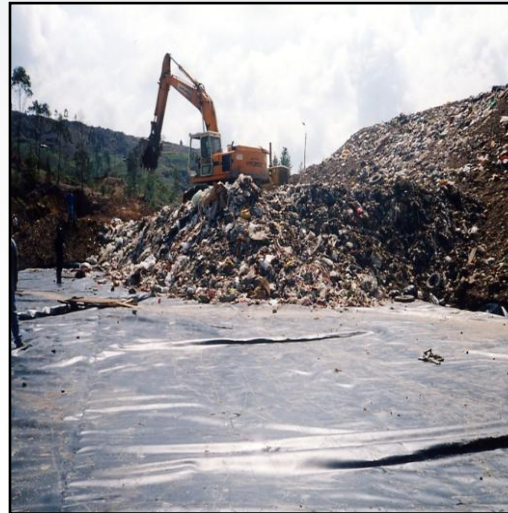
Operación del relleno sanitario en celdas por terrazas
