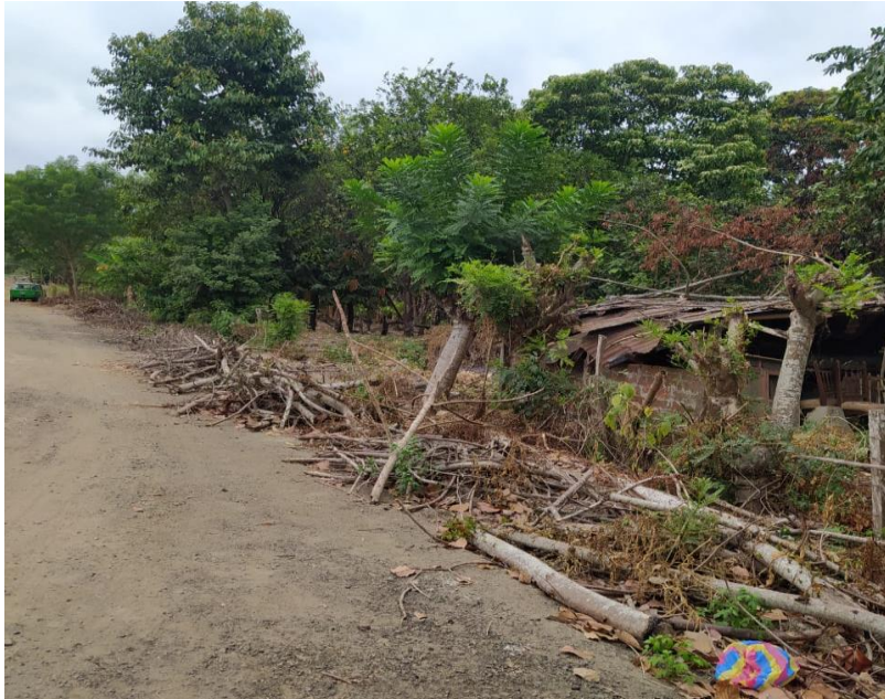
Figura 1.9 Cerramiento de lagunas de estabilización
