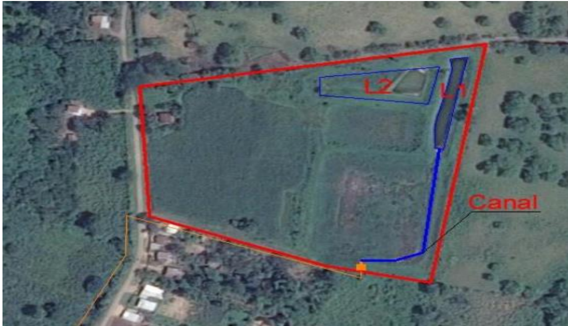
Figura 1.15 Lagunas de estabilización hasta el año 2016. En rojo superficie total destinada para la planta depuradora de aguas residuales
