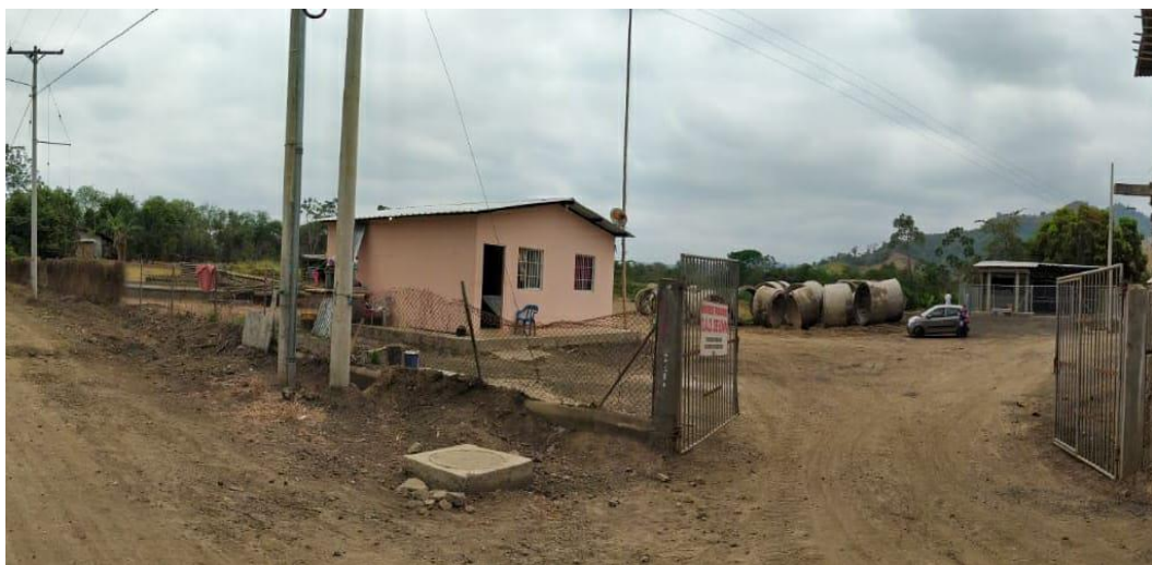
Figura 1.10 Falta de punto control de ingreso a lagunas de estabilización
