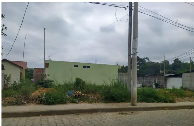
Figura 1.8 Asentamientos sobre línea de impulsión
