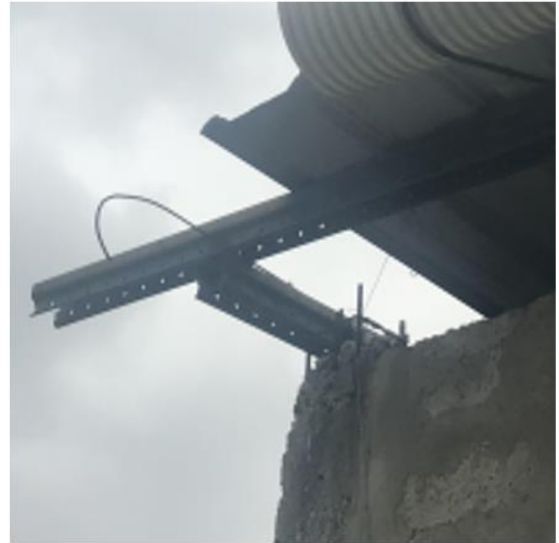
Figura 3.9 Inadecuada conexión de apoyo de estructuras de cubierta de perfil metálico [González & Loja, 2019]
