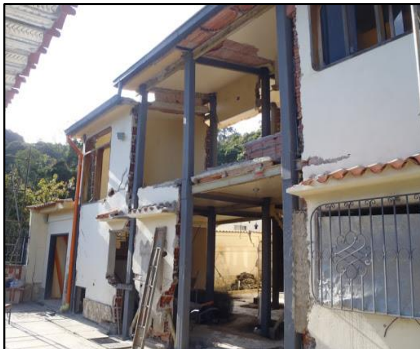
Figura 2.3 Reparación global de una vivienda de dos pisos [Sika Perú, 2015]
