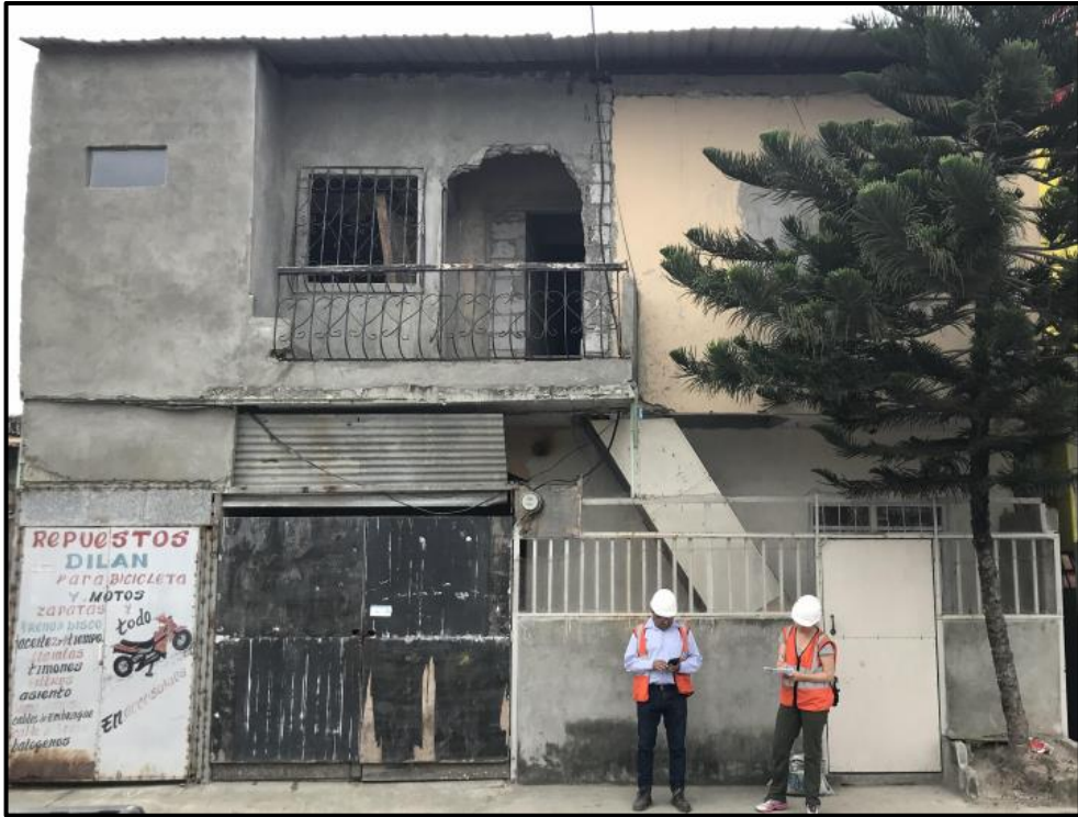
Figura 2.22 Vivienda de dos pisos con un local en la parte inferior [González & Loja, 2019]
