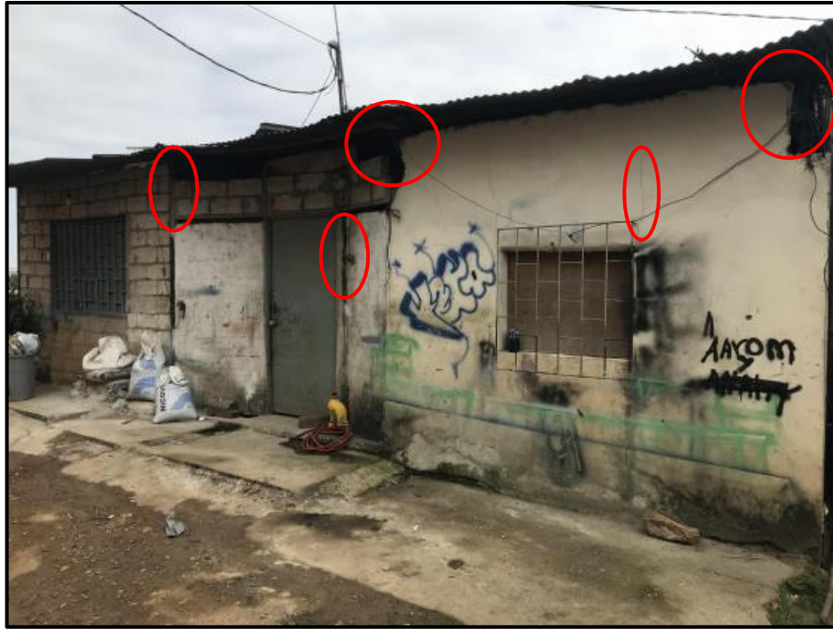
Figura 2.11 Vivienda residencial de hormigón de un piso [González & Loja, 2019]
