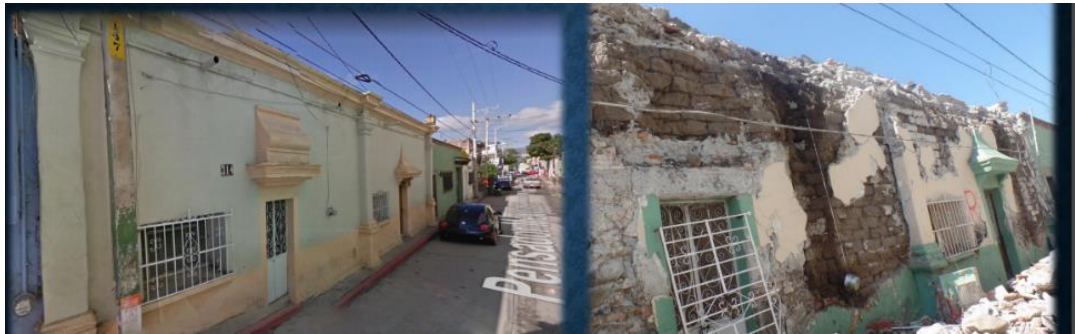
Figura 1.11 Vivienda de hormigón y ladrillos. [Fotografía: P. Rojas, 2017]
