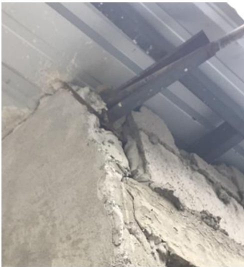
Figura 3.9 Inadecuada conexión de apoyo de estructuras de cubierta de perfil metálico [González & Loja, 2019]
