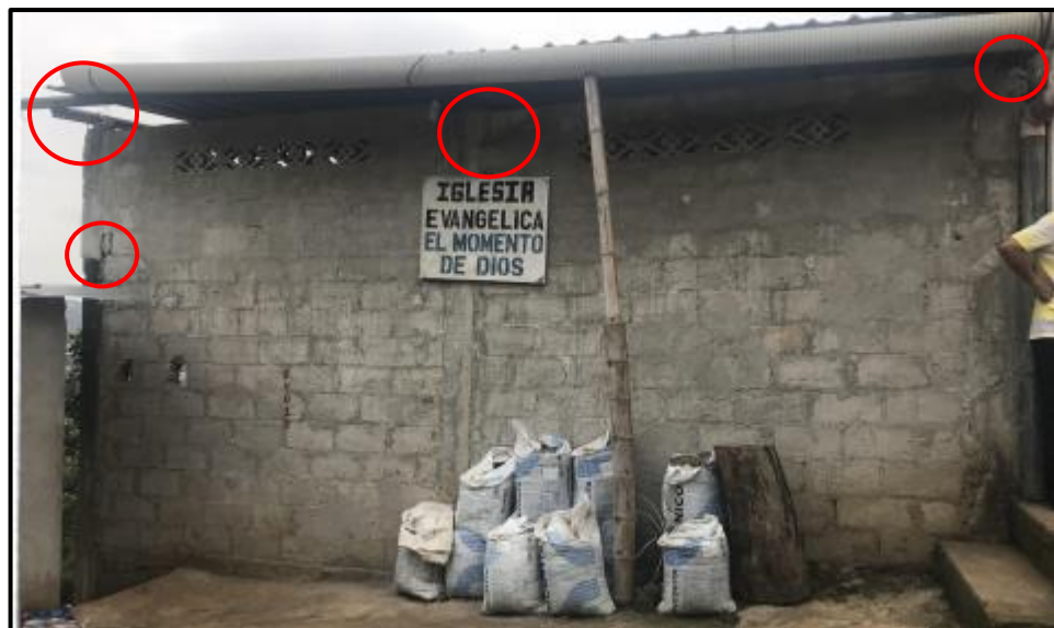
Figura 2.10 Iglesia Evangélica construcción de hormigón de un piso [González & Loja, 2019]
