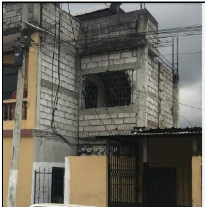
Figura 2.23 Ampliación lateral de una vivienda de dos pisos [González & Loja, 2019]
