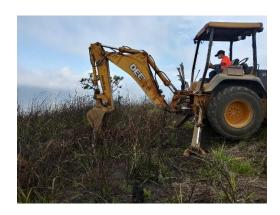
Figura 4.4. Excavación de calicatas con una abertura de 2 m x 2m, con la ayuda de una retroexcavadora
