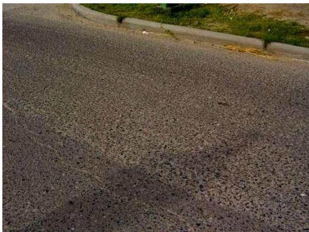
**Figura 2.2.12 Falla por peladura. Fuente: (Cálculo del índice de condición del pavimento flexible en la av. Luis montero, distrito de castilla, 2009).**
