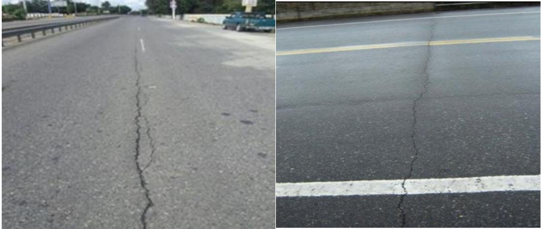
**Figura 2.2.2 Fisuras transversales y longitudinales. Fuente: (Grupo Técnico-Convenio 587-03, 2006).**
