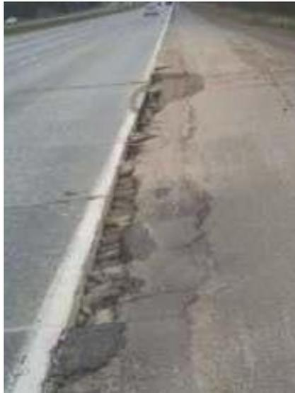
**Figura 2.2.13 Fisura en bordes. Fuente: (Manual para la inspección visual de pavimentos flexibles, 2006).**
