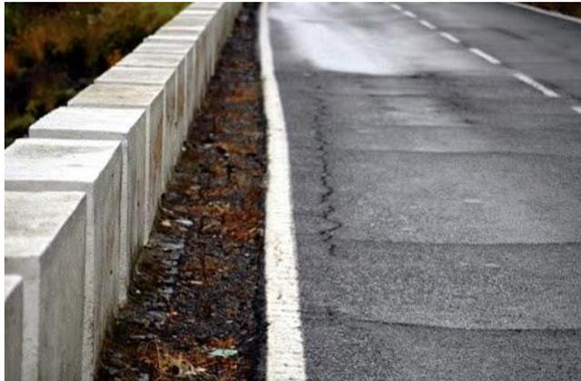
**Figura 2.2.8 Fisura por corrugación. Fuente: (Fallas en pavimento flexible, 2014).**
