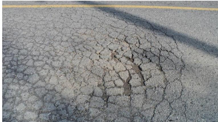
**Figura 2.2.1 Fisura Piel de cocodrilo. Fuente: (Fallas en pavimento flexible, 2014)**
