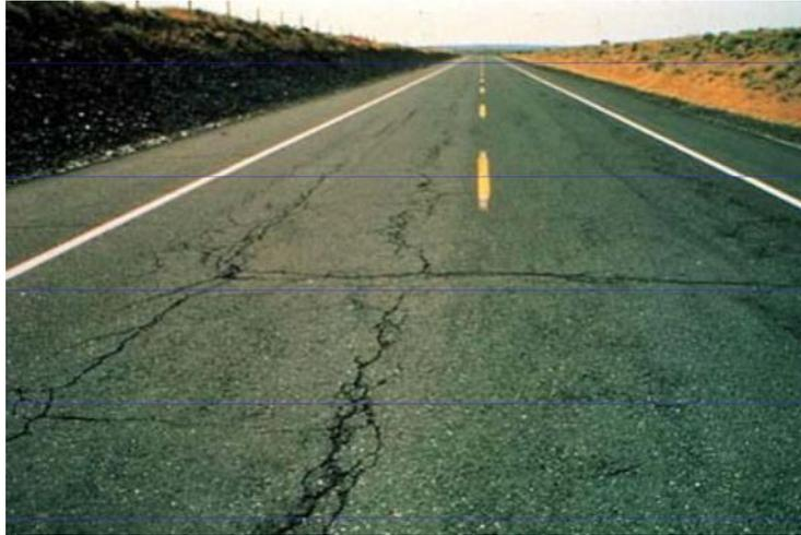
**Figura 2.2.3 Fisura en bloque. Fuente: (Corredor & Corros, 2010)**
