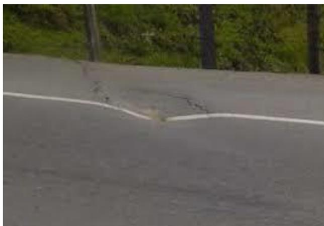
**Figura 2.2.9 Fisura por hundimiento. Fuente: (Grupo Técnico- Convenio 587-03, 2006).**
