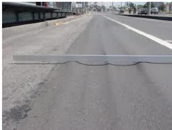
Figura 2.2.6 Fisura por ahuellamiento. Fuente: (Rondón 2012).
