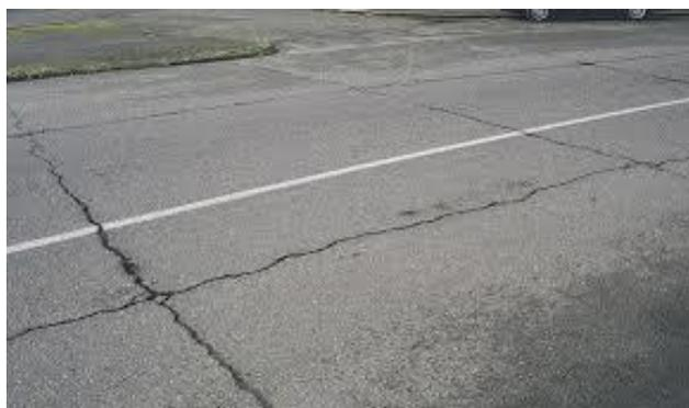
**Figura 2.2.4 Fisuras por reflexión de juntas. Fuente: (Tipos de causas, niveles de severidad y procedimientos de reparación en fallas en pavimentos asfálticos, 2008).**
