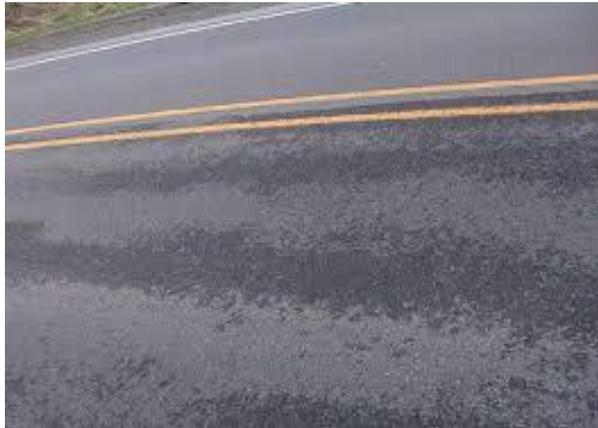
**Figura 2.2.14 Exudación de asfalto. Fuente: Manual para la inspección visual de pavimentos flexibles (2006).**
