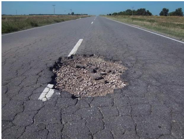
**Figura 2.2.11 Fisura de bache. Fuente: Manual para la inspección visual de pavimentos flexibles,2006).**
