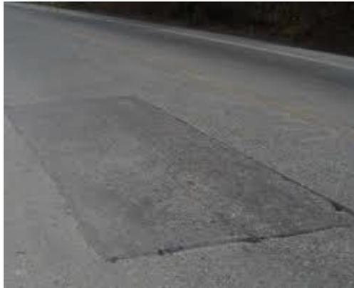
**Figura 2.2.15 Parchado. Fuente: (Manual para la inspección visual de pavimentos flexibles, 2006).**
