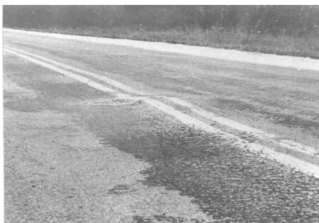
**Figura 2.2.10 Fisura por hinchamiento. Fuente: (Departamento de administración y evaluación de pavimentos- Dirección general de reglamentos y sistemas, 2016)**
