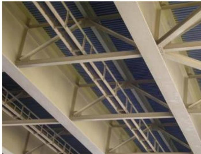
Figura 1-7 Puente tipo viga sobre marcos cruzados. Fuente: (Federal Highway Administration, 2015)
