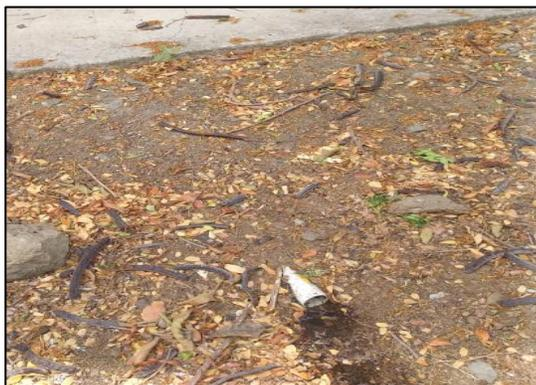
**Figura 2.11. Conexión ilícita**
