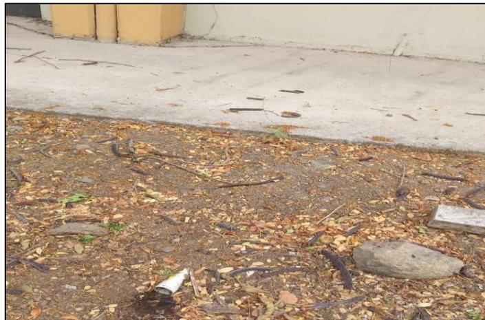
**Figura 2.23. Tubería de 5cm con salida a espacios libres.**
