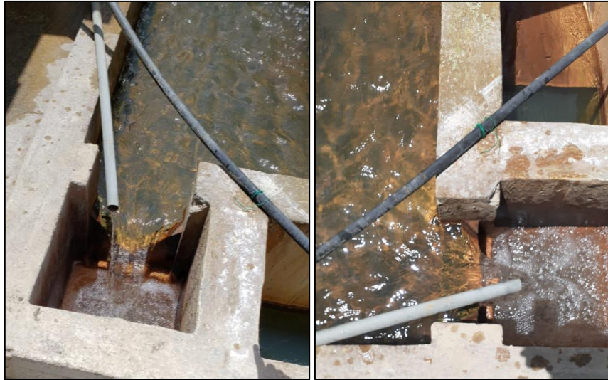
Figura 2.10 Vertedero de mezcla rápida
