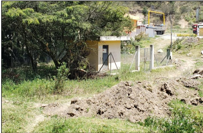
Figura 2.7 Vista del cárcamo de bombeo
