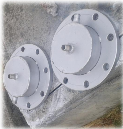
Figura 69. Bridas del tamiz molecular pintadas. Fuente: (Pactong, Solange; Salinas, Marcelo.)
