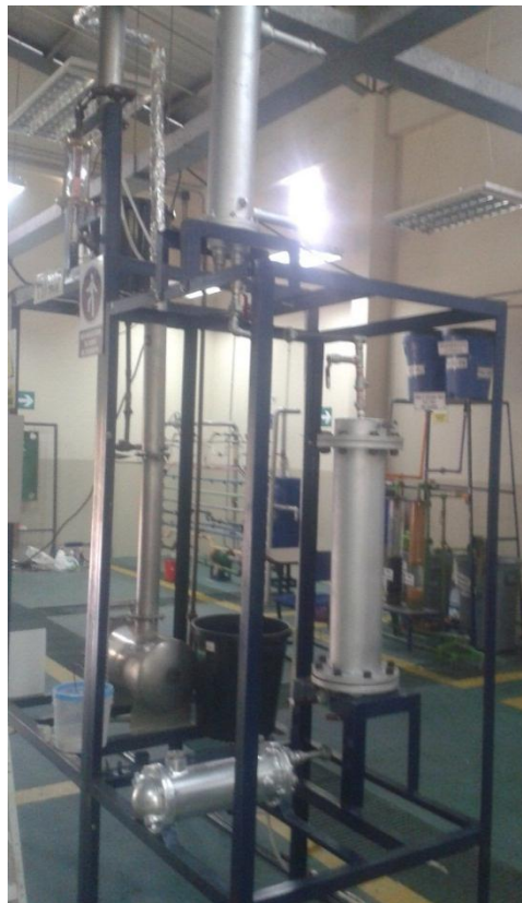
Figura 23. Estructura con los equipos montados.
