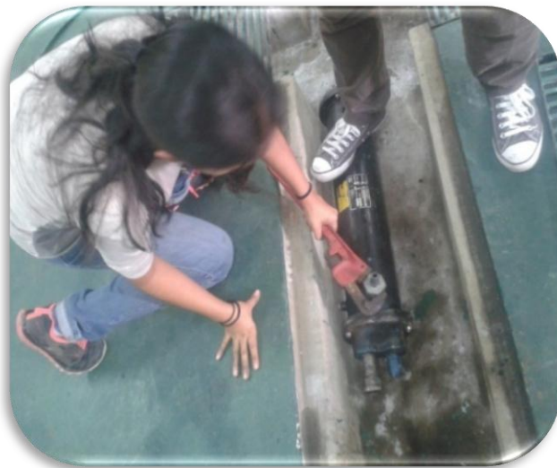
Figura 14. Colocación de accesorios para la prueba hidrostática.
