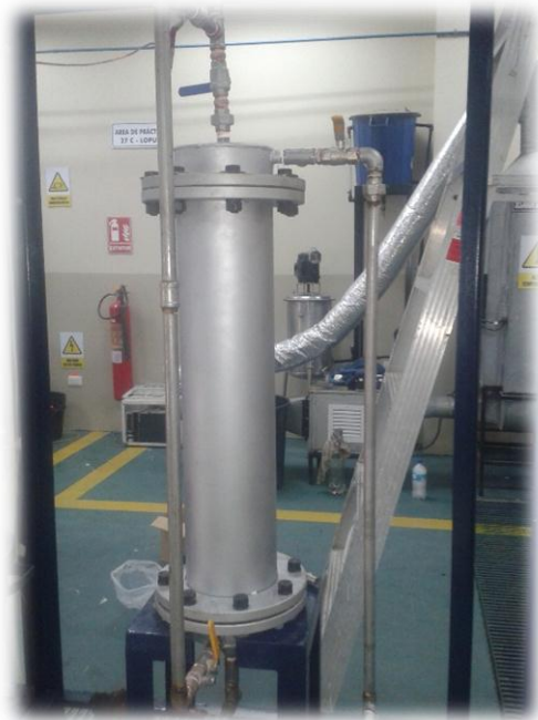
Figura 25. Sistema con líneas de proceso construidas.
