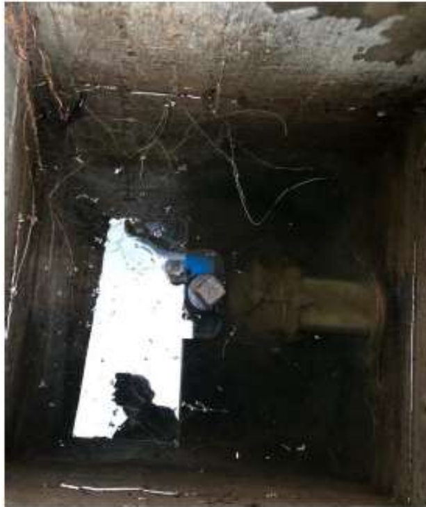
Figura 2.15. Válvula cubierta con agua. [Obtenido de: Catastro red AAPP ESPOL]
