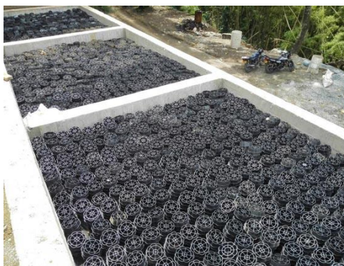
Figura 3.1 Aros plásticos usados en filtros para aguas residuales
