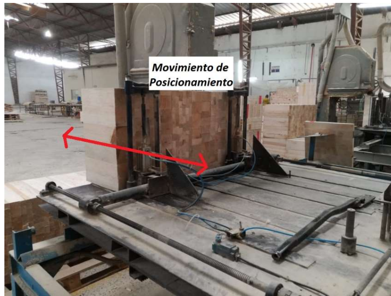
Figura 3.46 Movimiento de posicionamiento de los bloques
