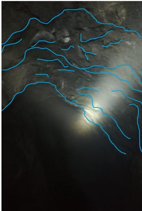
**Figura 3.22** Envolverte de rotura antes de la aplicación del método de Holmberg
