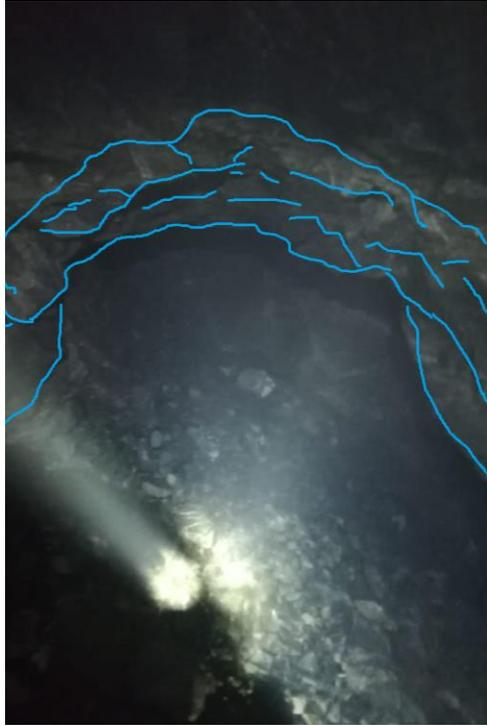
**Figura 3.21** Envolverte de rotura después de la aplicación del método de Holmberg
