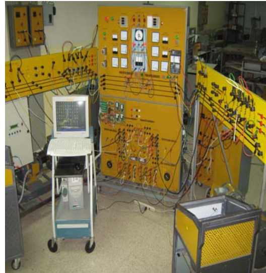
Figura 17. Figura de la practica de sincronización de generadores en paralelo.
