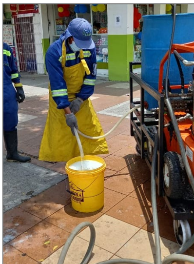
Figura 3.4 Preparación de mezcla a base de sustancias químicas
