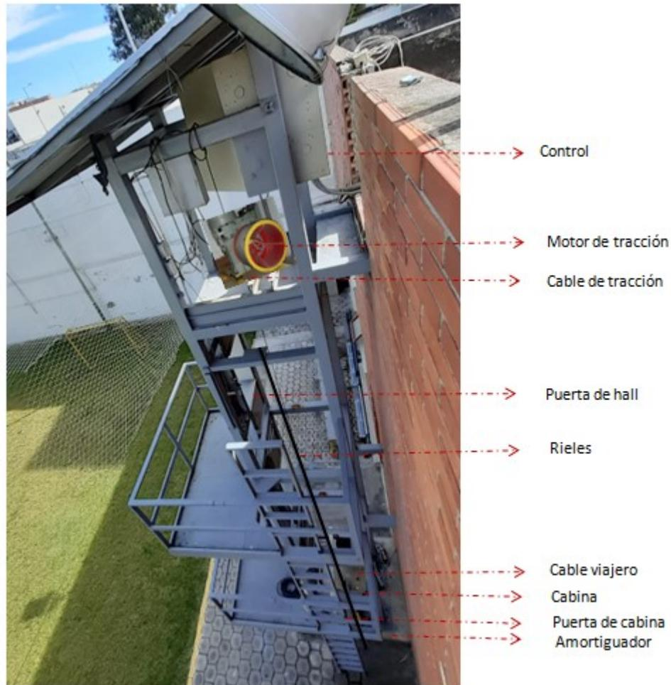
**FIGURA 3.4 COMPONENTES DE UN ELEVADOR DUMBWAITER**
