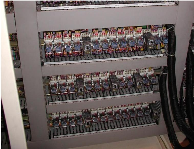
Figura 2.1 Circuito de lógica cableada [6].
