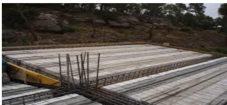
Ilustración 3.15 Material prefabricado para complementar losa
