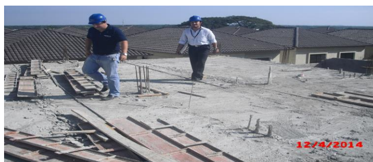
Ilustración 3.16 Fundida de losa con material prefabricado
