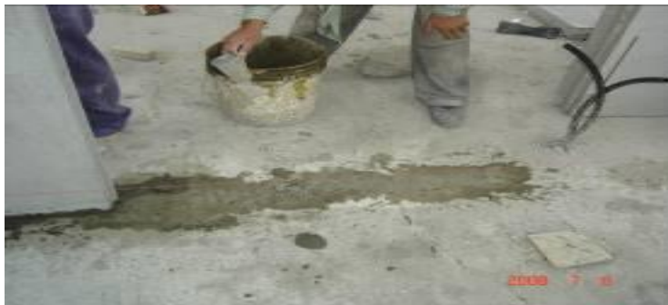
Ilustración 3.17 Retoques después de la fundición de la losa
