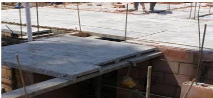
Ilustración 3.14 Colocación de material prefabricado
