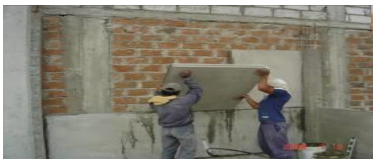
Ilustración 3.19 Colocación de material prefabricado a una pared
