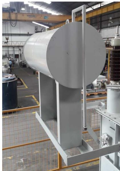
**Figura 1.7. Tanque de expansión, aquí el aceite dieléctrico se almacena herméticamente. [Moretran, 2019]**
