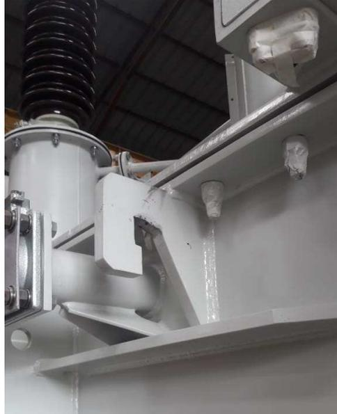
**Figura 1.6. Las orejas de izado usado para acoplar ganchos y levantar el transformador. [Moretran, 2019]**
