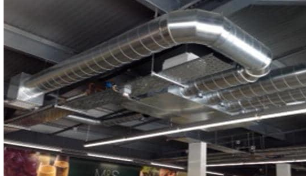
Figura 1.7 Ductos circulares para flujo de aire (Fuente: Nergiza)
