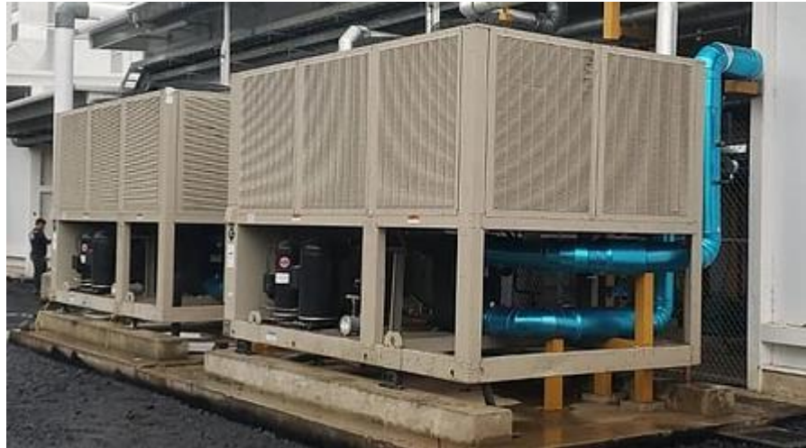
Figura 1.2 Imagen de equipo tipo Chiller (Fuente: Mechanical Projects S.A.)
