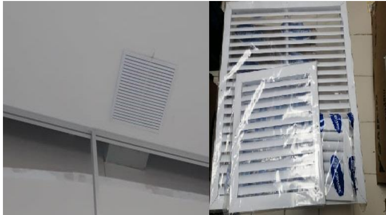
Figura 1.10 Diferentes tipos de rejillas (Fuente: Elaboración propia)
