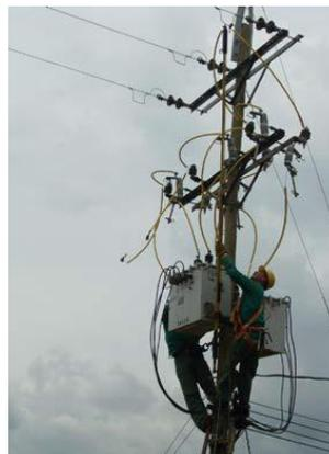
Figura 9. Instalación eléctrica para acometida de la bomba
