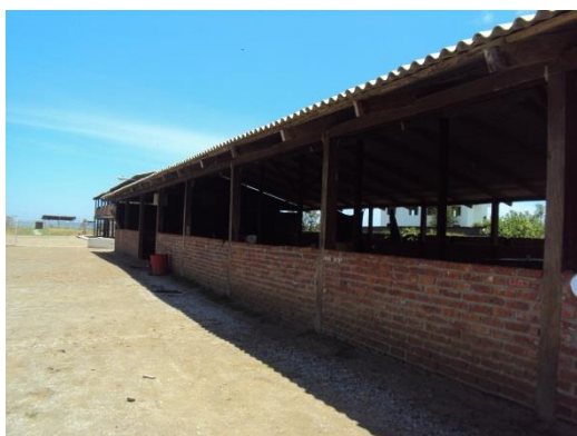
Figura 1. 2 - Instalaciones del Campamento el Faro.
