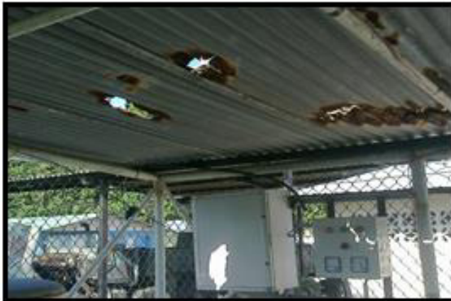
Gabinete de control en Calime
