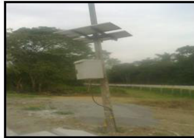
Gabinete de las baterías del panel solar, con su respectivo radio para accionar los actuadores y permitir el paso del agua hacia el CALIME y BATALLON
