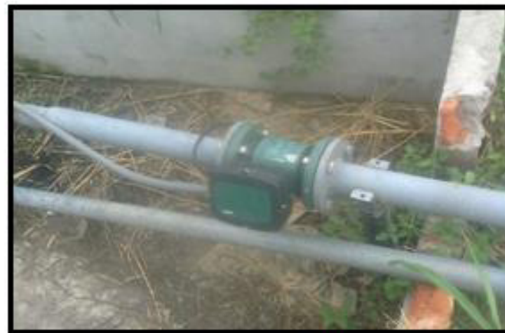
Colocación de sensor de caudal en estación de bombeo del BIMESM
