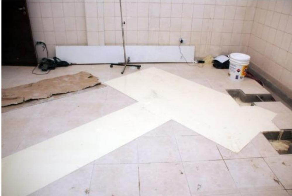
**Figura 4.2** Plantilla de instalación de tomógrafo, [33]
