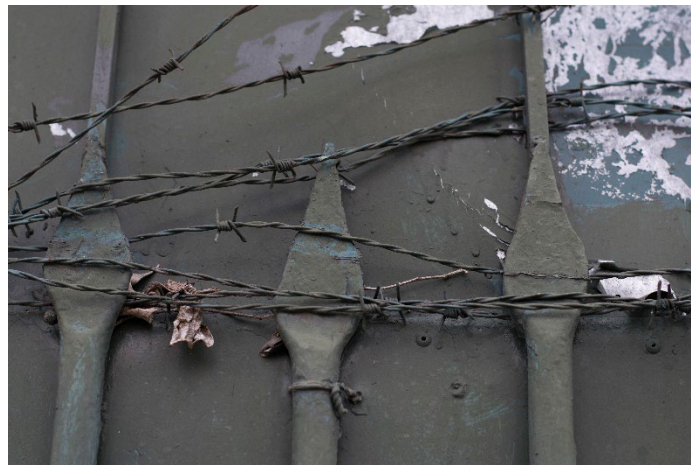
Figura 2.2 Reja exterior casa patrimonial, Luque 2115 entre Carchi y Tungurahua
