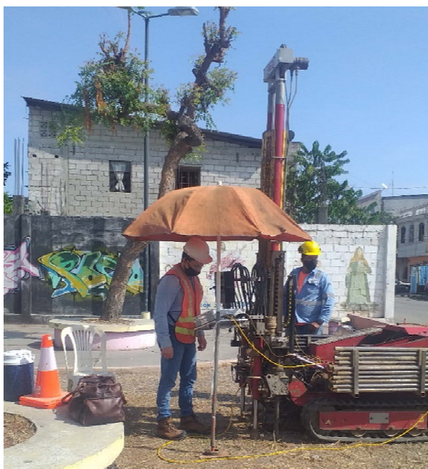
Figura 3.3. – Ejecución de CPT-44 (Sector Guasmo Libre)
