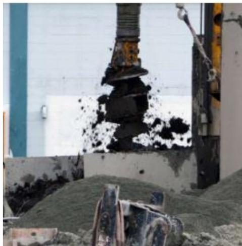
**Gráfico 23 Barreno helicoidal para avance en profundidad.**
