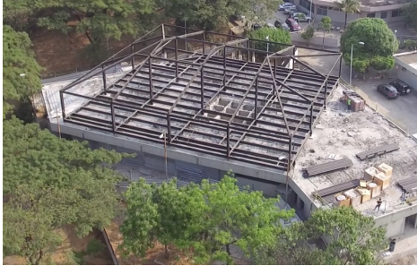
Edificio en construcción (ESPOL bloque 32d)
