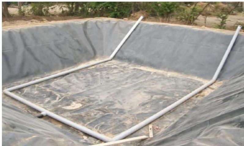
**Figura 3.11** Conformación de la piscina de drenaje
