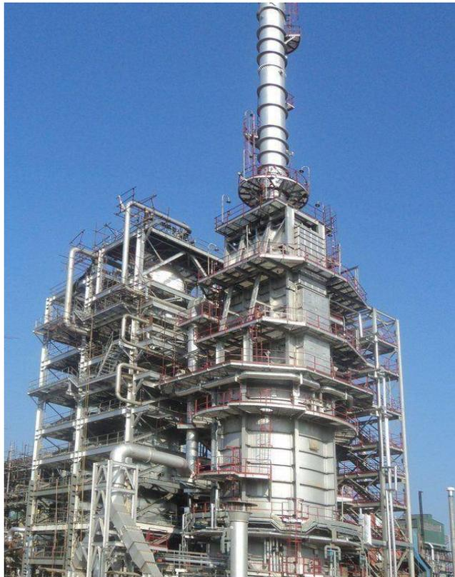
**Figura 1.1 - Horno de Refinería**
