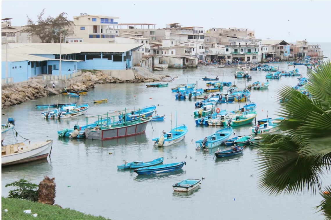
Figura 3-1: Puerto Pesquero de Santa Rosa, zona inundable de alta vulnerabilidad 23 .
