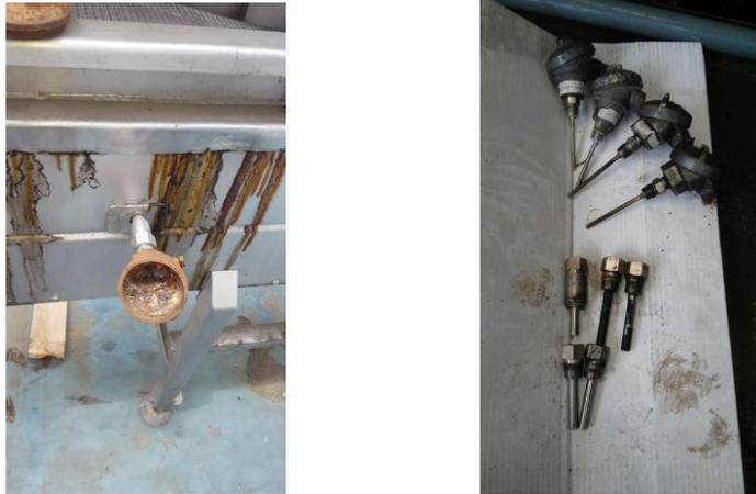
Figura 1. Sensores de temperatura en malas condiciones
