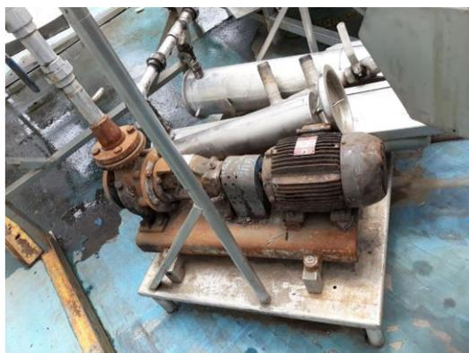
**Figura 5. Motor y bomba de aceite térmico**
