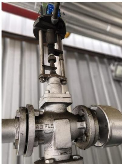
**Figura 8. Actuador motorizado regulador de flujo**
