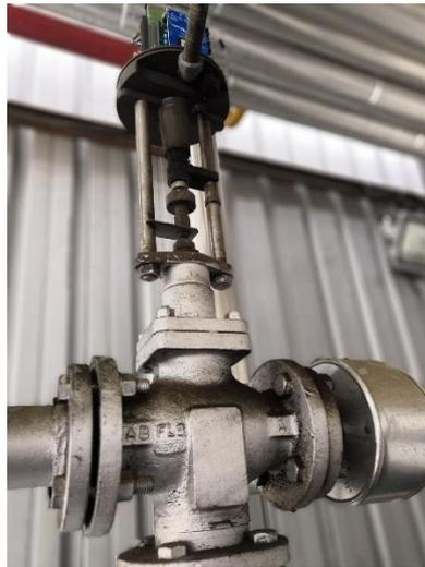
**Figura 2. 1, Actuador motorizado**
