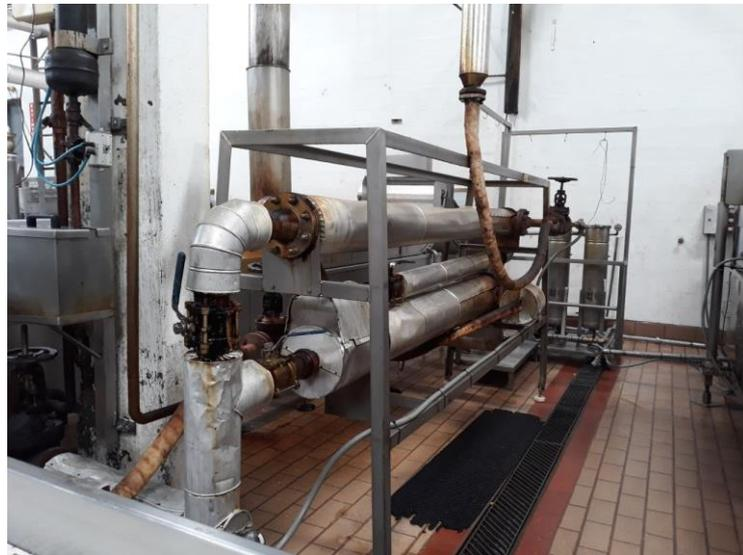
Figura x Intercambiador de calor
