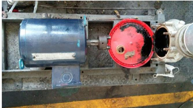
**Figura 6. Cambio de Motor de la bomba de aceite térmico**
