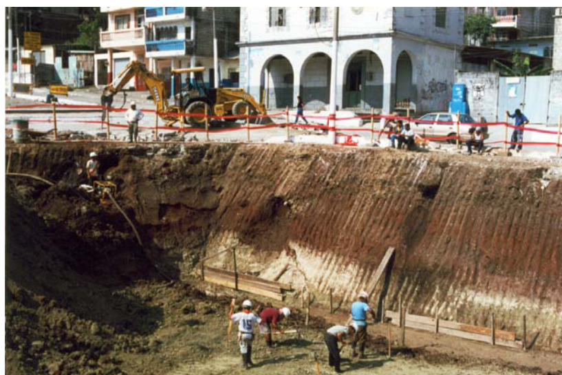
FOTO 6B: Vista de intervención por construcción de túneles en Teatro Juan Pueblo (2000)
