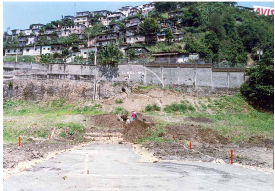
FOTO 6D: Excavación de trinchera al interior del Patio Sur del Hospital Lorenzo Ponce (Proyecto Túnel II, 2000).
