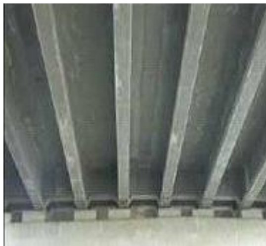
FIGURAS 2 Y 3. Puente Bourges-les-Valence primer puente vehicular con HUAD del mundo, Francia. Vigas principales pre-esforzadas.
