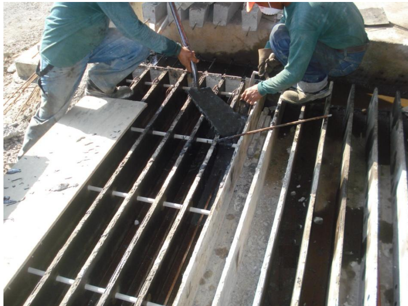
FIGURA 25. Vertido del hormigón de alto desempeño en los moldes de las viguetas pretensadas.
