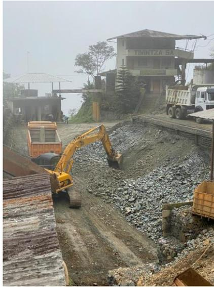
**Figura 1. Disposición de material de caja y desalojo de escombrera**
