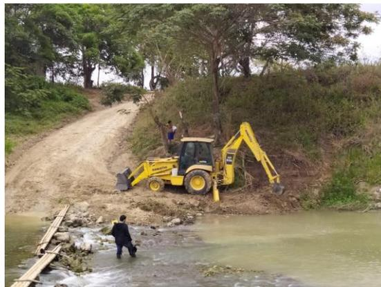
**Figura 0.6. Toma de muestras con retroexcavadora**
