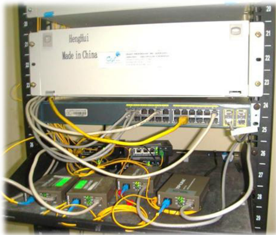
Figura 4.4 Enlaces de Fibra Óptica
