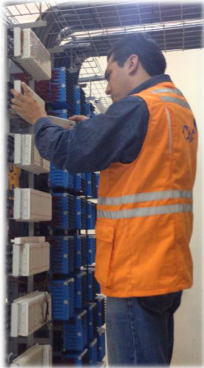
Figura A.2 conexión de nuevo abonado
