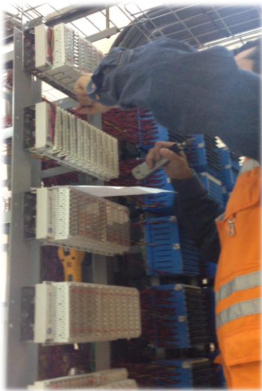
Figura A.4 Conexión de nuevo abonado
