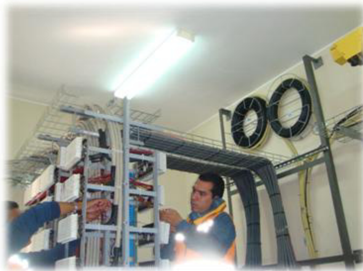
Figura A.1 Conectando un puente
