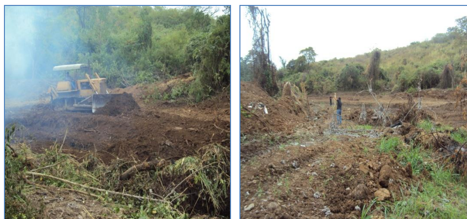
Figura 7.2. Fase de desbroce para el proyecto
