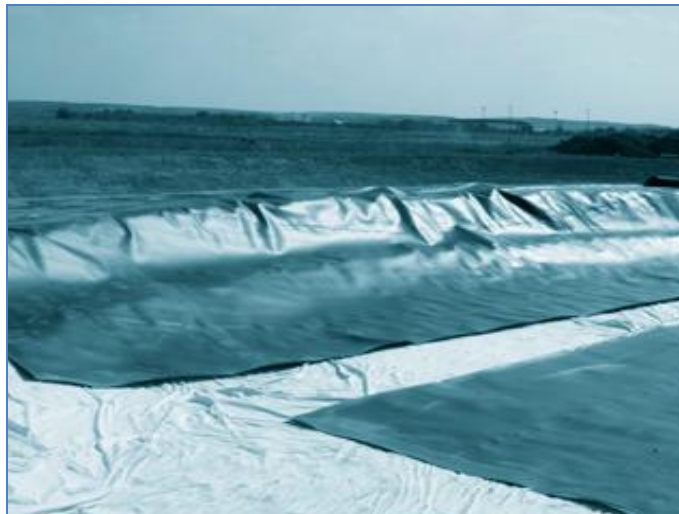
Figura 7.1. Instalación de una geomembrana para Sistemas de Lagunaje.
