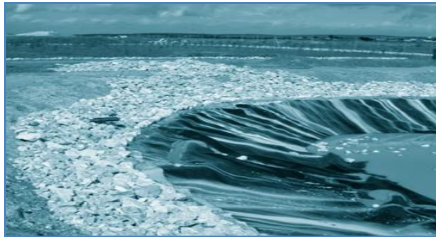
Figura 7.4. Modo de protección de los taludes.
