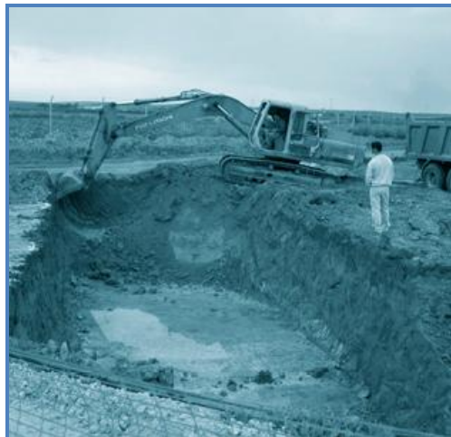
Figura 7.3. Ejemplo de excavación para los sistemas de lagunaje.
