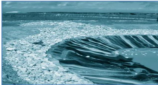
Figura 7.4. Modo de protección de los taludes.
