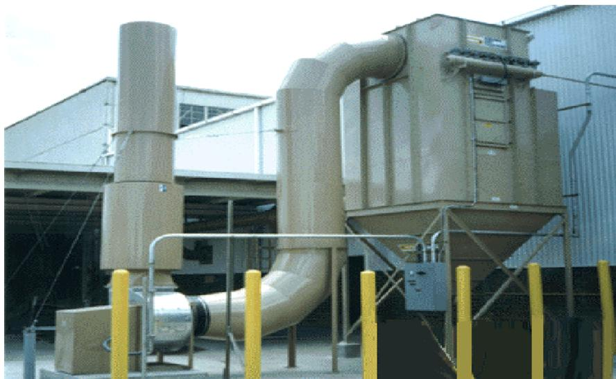
**FIGURA 3.5** Filtro de mangas Pulse Jet.
