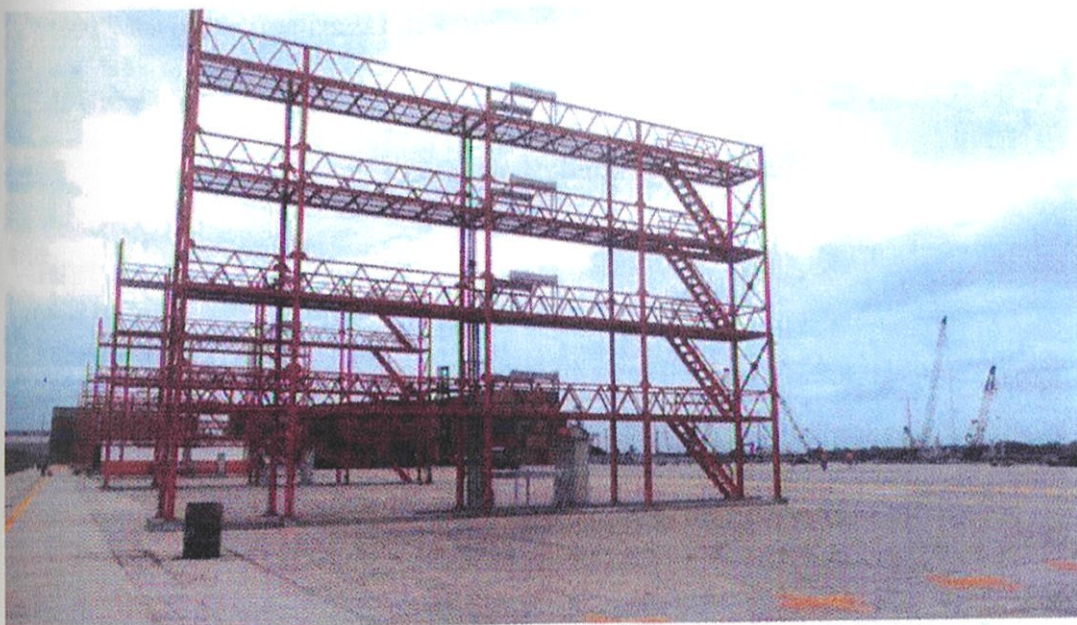
Gráfico # 42. Instalaciones Contenedores Refrigerados
