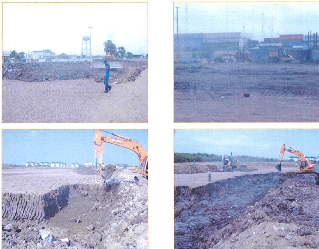
Gráfico # 35. Avance de obras del Terminal de Frutas
