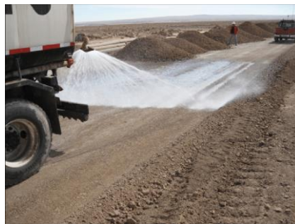
Figura 4.5. Riego de agua sobre el camino arenoso de acceso a la zona de implantación
