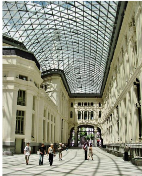
Figura 1.2. Palacio Cibeles con cubierta de malla espacial de una capa
