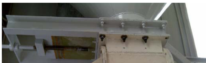
FIGURA 5.16 - VÁLVULA GUILLOTINA COMPLETAMENTE INSTALADO.
