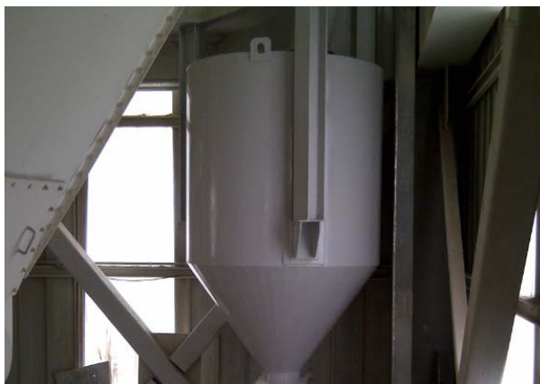
FIGURA 5.15 - SILO COMPLETAMENTE INSTALADO
