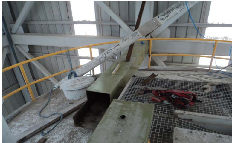
FIGURA 5.3 - PREENSAMBLE DE VIGA CAJÓN CENTRAL
